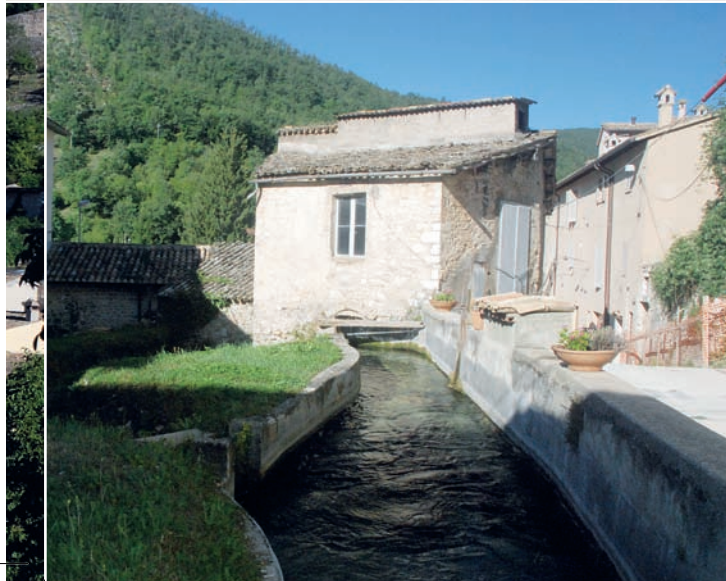
Panorama dall'alto del castello di Montesanto, con i ruderi delle mura. In basso, da sinistra, un camper in sosta a Cerreto di Spoleto e tre immagini di Rasiglia: una vista del borgo, le acque della sorgente Capovena che scorrono fra le case e la torre, l'unico elemento superstite della rocca.
