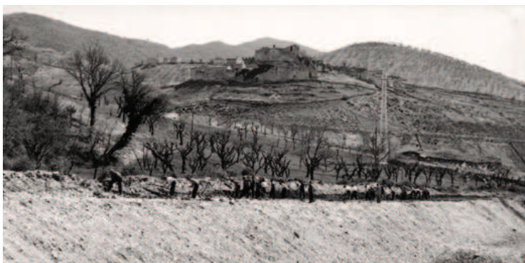
36. Cantiere della rete viaria di Strettura. Spoleto, anni cinquanta del Novecento.
